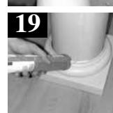
8. Utilice una escofina de madera para nivelar la parte superior del eje de la columna. Mida de la parte superior de la columna a la longitud apropiada y haga una serie de marcas alrededor del eje de la columna.
