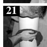
10. Corte la columna usando una sierra circular abrasiva. ADVERTENCIA: Debido a que la columna soporta peso, los bordes inferiores y superiores deben nivelarse para alcanzar contacto completo y uniforme entre las superficies de la carga y el eje. Utilice una escofina para nivelar según lo requerido.
